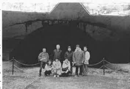
築城基地横に残る掩体壕の正面
